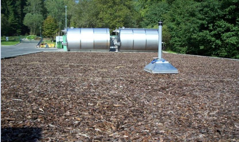
Biofilter, Fläche mit vertikaler Durchströmung
