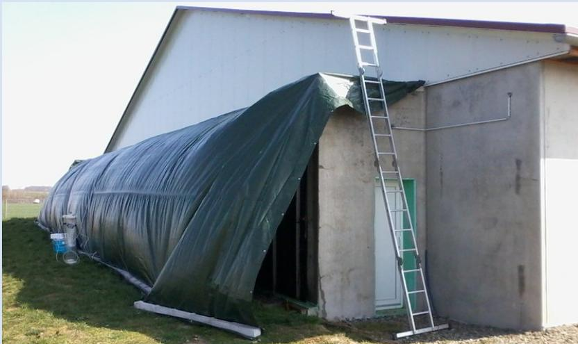
Biofilter, Fläche mit horizontaler Durchströmung
