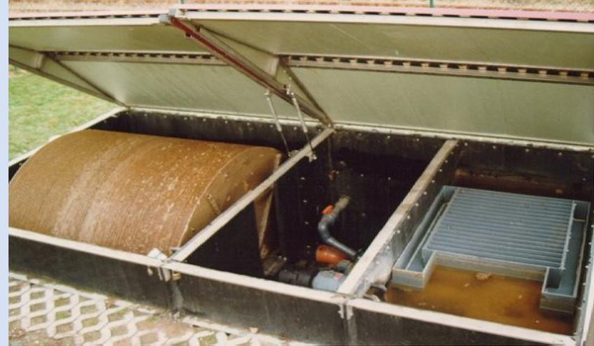
Kleinkläranlage mit passiver Oberfläche
